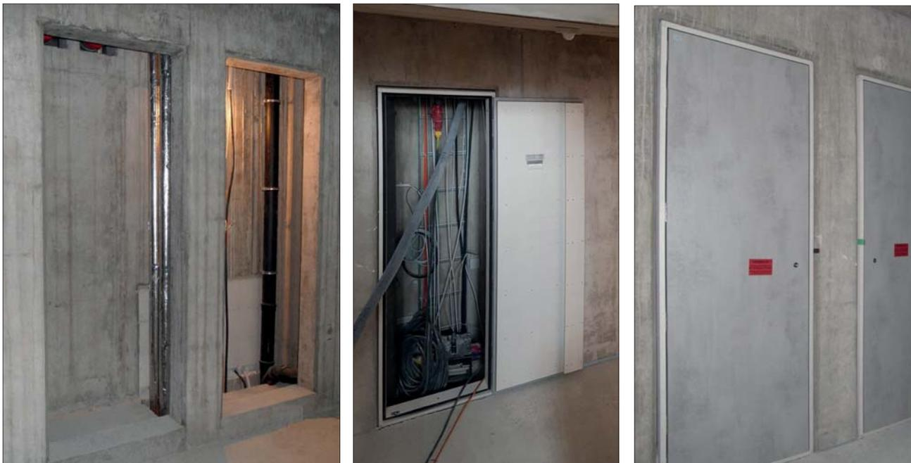
Beim Eisbärhaus kam die flächenbündige Variante **UPT-AK mit Anputzkante** zum Einsatz, bei der nach der Fertigstellung nur der Türflügel sichtbar bleibt. Die geforderte zurückhaltende Optik wurde zudem durch die Anpassung der Türoberflächen an die Betonstruktur der Wand erreicht. Damit wurden nicht nur den gesetzlichen Brandschutzvorgaben Genüge getan, sondern es konnten auch die gestalterischen Vorgaben des Planers zu dessen vollster Zufriedenheit umgesetzt werden.
