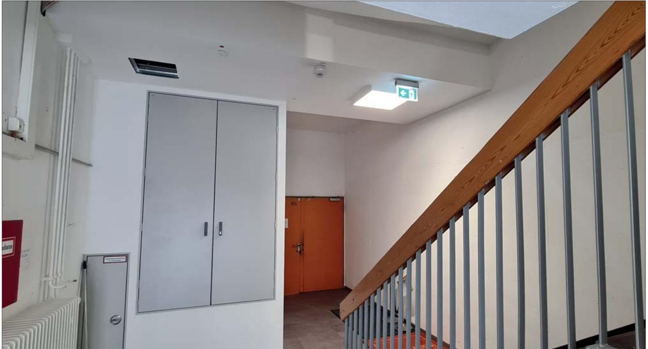
Der klassische Anwendungsfall für den Einsatz eines Revisionsabschlusses: Die feuerwiderstandsfähige Abschottung von Wandöffnungen vor einem Installationsschacht im Flucht- und Rettungsweg.
