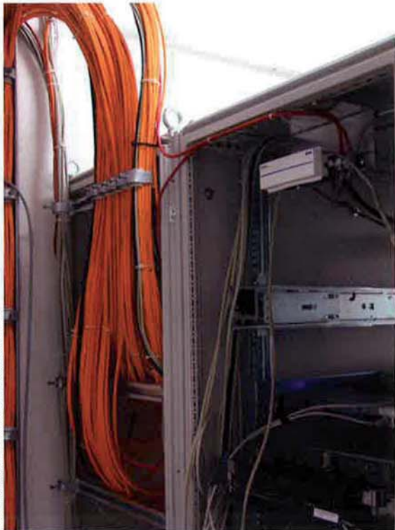
Bild | Die Überwachungsgeräte von Securus 90 überwachen ständig den Innenraum der Schaltschränke und leiten die ermittelten Werte an eine zentrale Stelle weiter.
