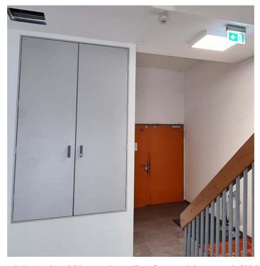
Grundanforderung an Revisionsabschlüsse ist die feuerwiderstandsfähige Abschottung von Wandöffnungen vor einem Installationsschacht in Flucht- und Rettungswegen.
