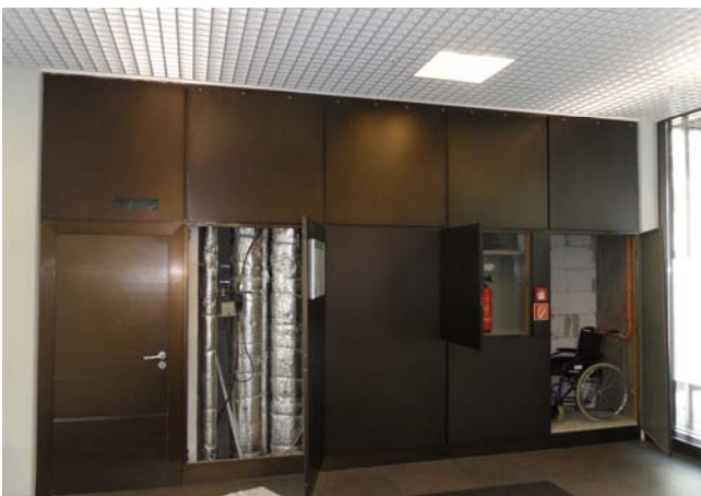
Alte Wandverkleidung und freigelegter Installationsschacht
