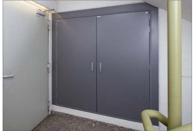
Nach dem Umbau: Zweiflügeliger Revisionsabschluss SECURUS RV-W-UPT90, Wandversion, flächenbündig in die Wand eingebaut.
