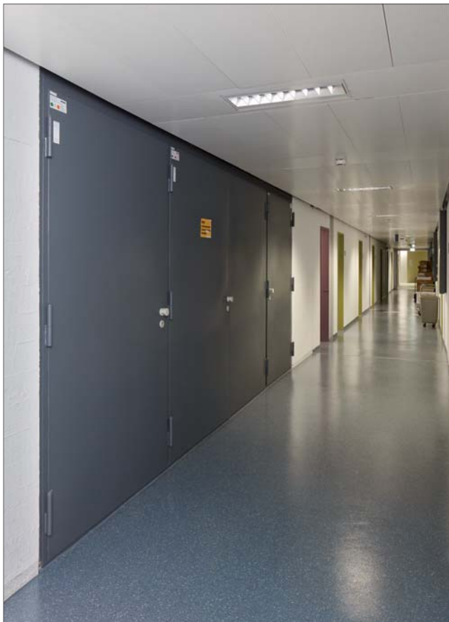
Vor dem Umbau: Alte Revisionstüren aus Stahl ohne Feuerwiderstand vor den Schächten im Flurbereich der jeweiligen Stockwerke.
