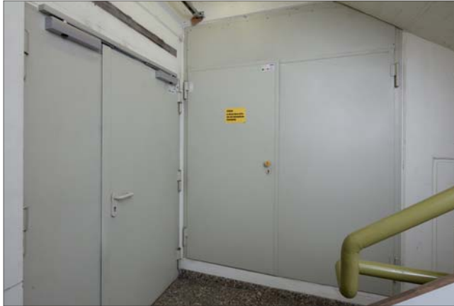
Vor dem Umbau: Alte Blechtüren ohne Feuerwiderstand vor den im Treppenhause verlaufenden Installationsschächten.
