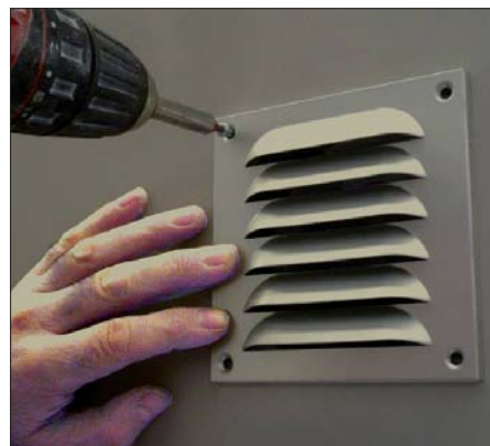
Bild 2: Anschrauben der Lüftungsblende
